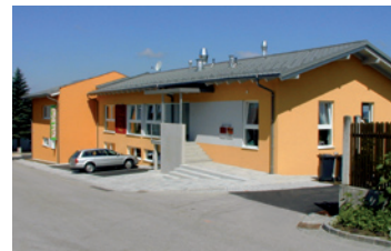
Abb. 02. Kommunikationszentrum Quelle: Marktgemeinde Allhartsberg
